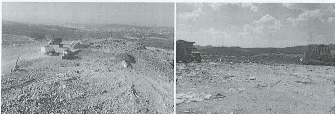
Imagen 10. Compactación y conformación de celdas.
