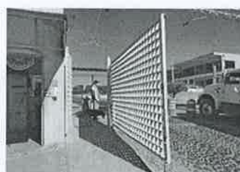
Imagen 8. Control de acceso
