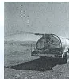
Imagen 5. Recirculación de lixiviados.
