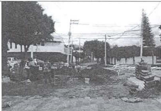
Calle Fray T. Benavente esquina Fray Sebastián de Aparicio (se encuentran colocando adoquín de cantera rosa)
