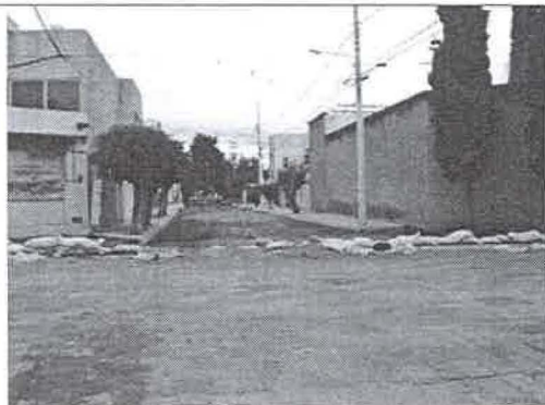
Calle Motolinía de la calle Olmos a Francisco Kino (falta colado de banquetas y colocación de adoquín)
