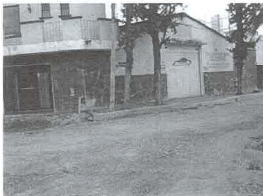
Calle Fray Juan de Talavera de Fray Sebastián de Aparicio a Fray Bartolomé de las Casas (falta colocación de adoquín)
