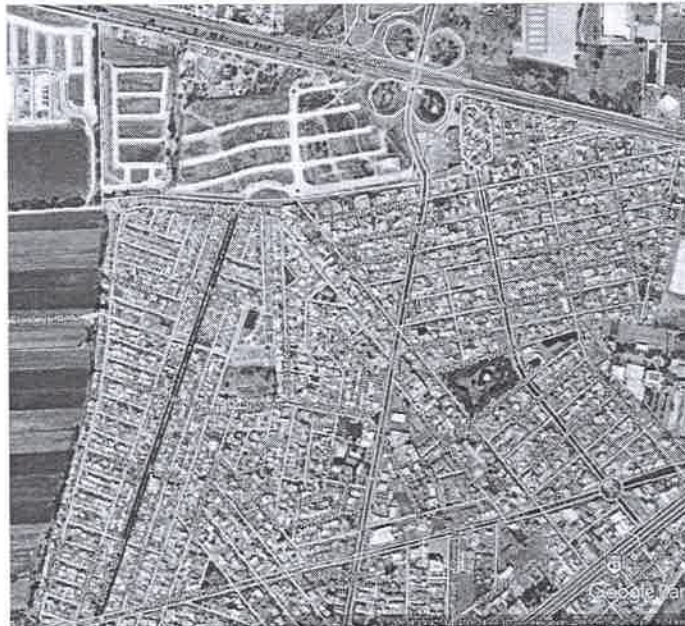
Indica obra extraordinaria, re encarpetao asfáltico de 5 y 7 cm de espesor.
