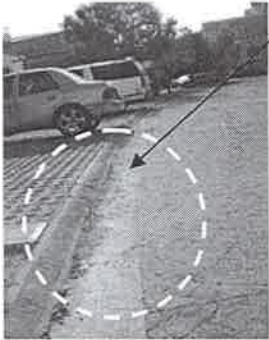
Área de ruptura de pavimento en calle camino real de carretas
