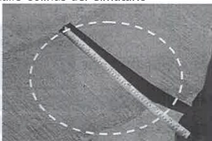
Área de ruptura de pavimento en la calle Colinas del Cimatarío
