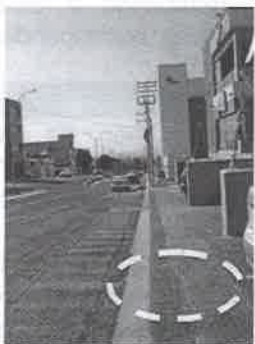
Banqueta de concreto, el acabado no es igual o similar al existente
