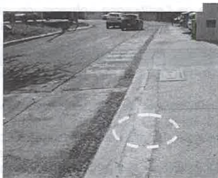
Banqueta de concreto, el acabado no es igual o similar al existente
