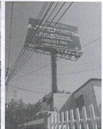
ANUNCIO ANU2017-00961 EL 10/05/2018, SE OBSERVÓ CON PINTURA DESLAVADA, Y SIN LUMINARIOS IGUAL QUE EL 20/02/2018
