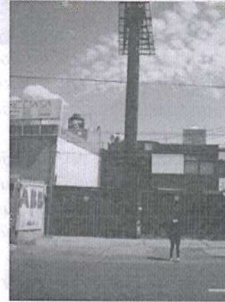
ANUNCIO ANU2017-00961 EL 20/02/2018, CON PINTURA DESLAVADA AL EXTERIOR DE LA EDIFICACIÓN Y SIN REFLECTORES.
