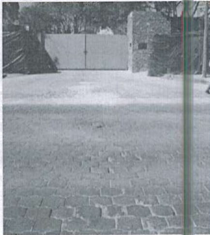
Condiciones físicas que presenta el sitio donde se realizaron los trabajos autorizados mediante licencia RUP201700171.
