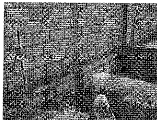
RANURAS VERTICALES SOBRE EL MISMO EJE (DENOTA FALTA DE PREVISIÓN PARA ALBERGAR INSTALACIONES EN HUECOS DE BLOCK)
